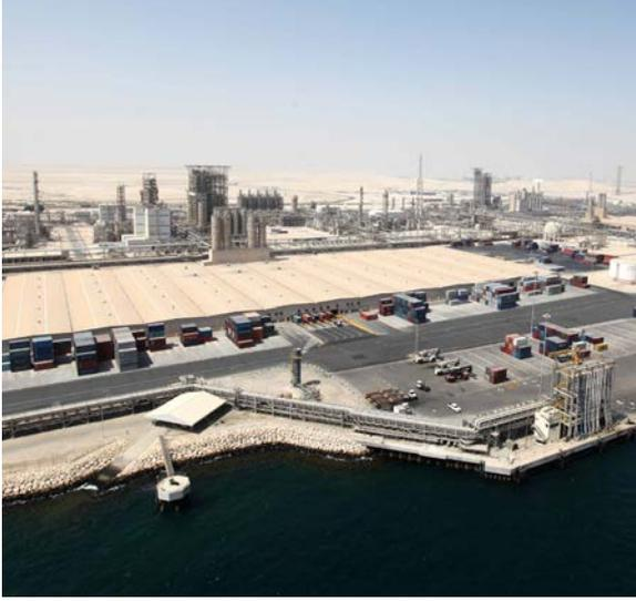
وتصل الطاقة الإنتاجية لمجمع شركة قطر للكيماويات المحدودة (كيوكيم) إلى 453,000 طن متري سنويًا من البولي إيثيلين و47,000 طن متري من هكسين-1. ويضم المجمع أيضًا وحدة لاستخلاص الكبريت وتحويله إلى حبيبات، ومحطة لمعالجة المياه، ونظام التبريد بمياه البحر ومرافق، ومباني إدارية.
